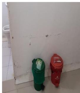
Paredes con discontinuidad en la pintura dado por humedad q permite la acumulación de polvo
