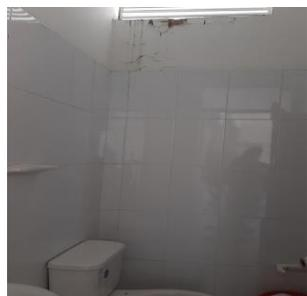
Baño de pacientes con palanca de la cisterna dañada, paredes con humedad con pérdida de la continuidad de la pintura, baños sin barandas de seguridad.
