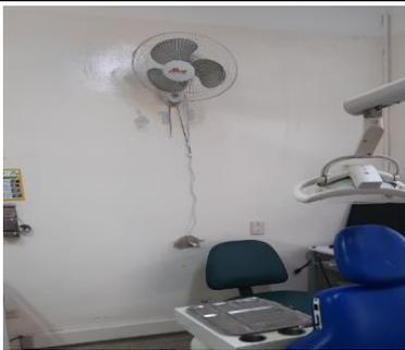
Paredes con discontinuidad en la pintura dado por humedad q permite la acumulación de polvo y humedad.
