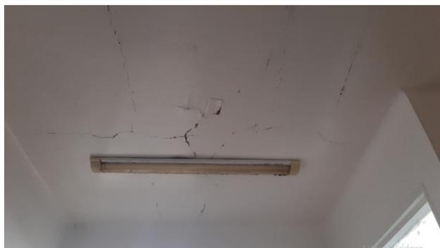
A la entrada de procedimientos el cielorraso esta agrietado y según informe de personal de enfermería cuando llueva cae gotera Sistema de cableado suelto y expuesto
